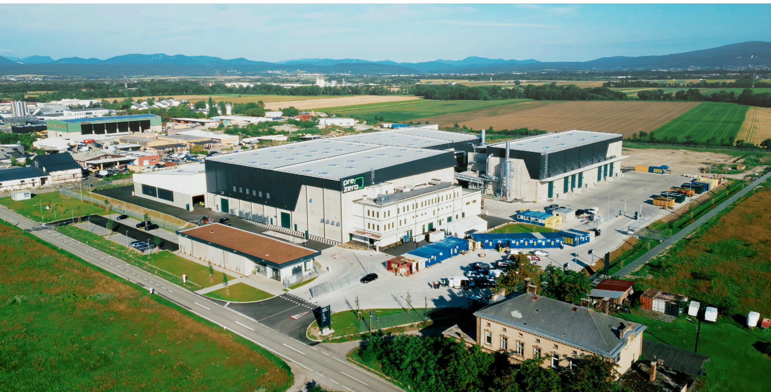
Moderne Sortiertechnik, intelligenter Brandschutz: die PreZero-Anlage in Sollenau.
